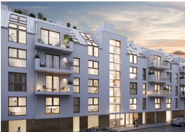
Schumannngasse | Fassade Straße
