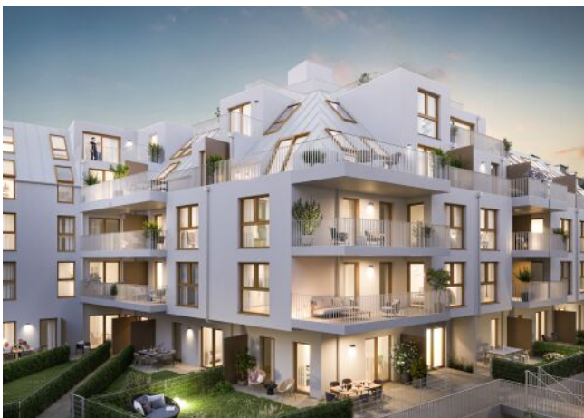
Schumanngasse | Fassade Abend
