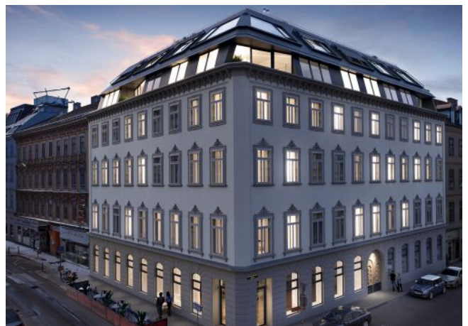
Essenz No. 1 | Fassade Abend
