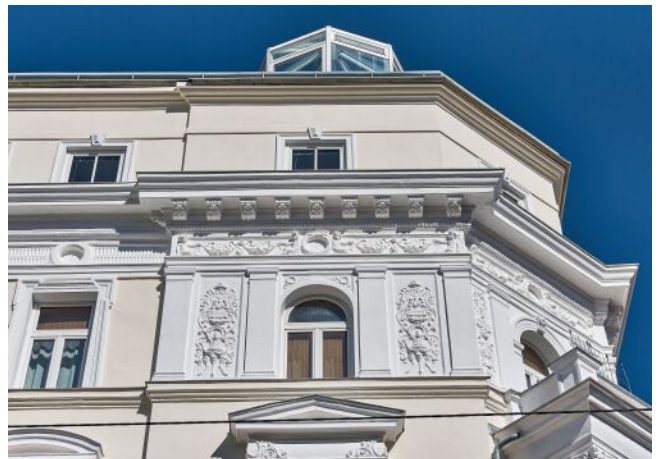
Leibenfrostgasse 8 | Fassade Detail
