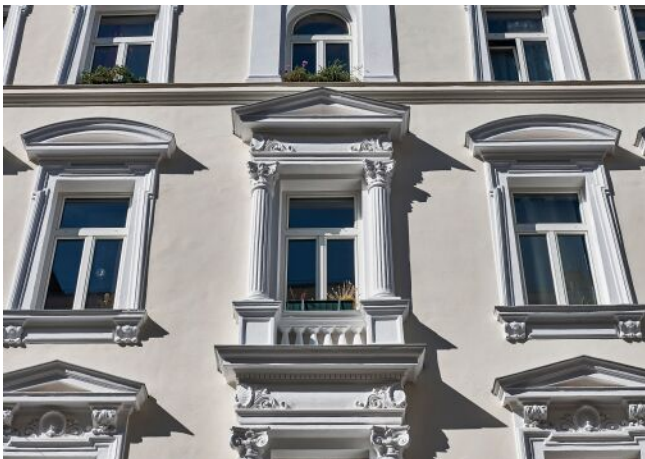
Leibenfrostgasse 8 | Fassade Detail
