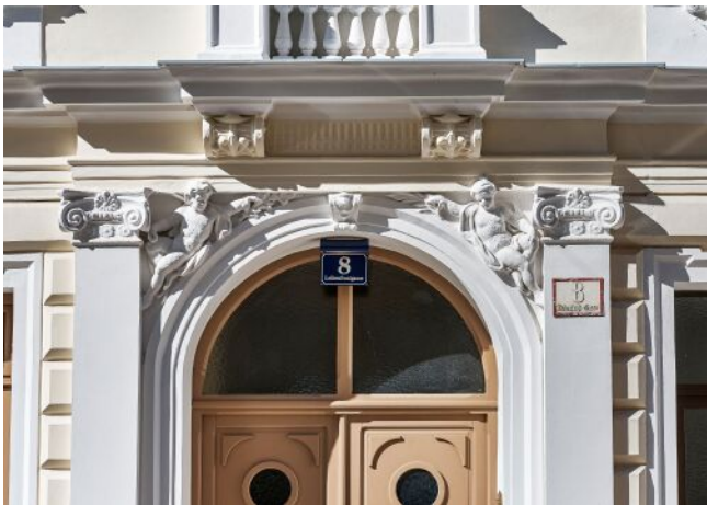
Leibenfrostgasse 8 | Fassade Detail
