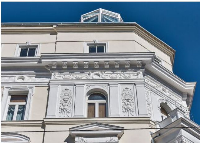
Leibenfrostgasse 8 | Fassade Detail
