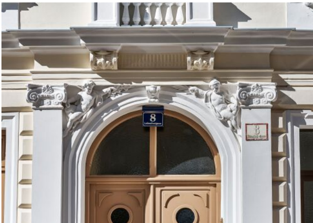
Leibenfrostgasse 8 | Fassade Detail
