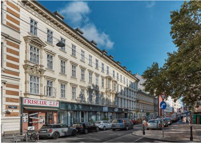
Schönbrunner Straße 20-24 | Fassade
