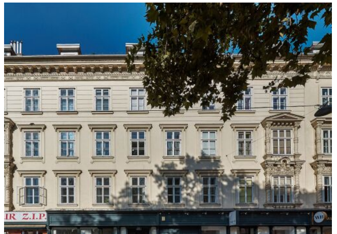
Schönbrunner Straße 20-24 | Fassade
