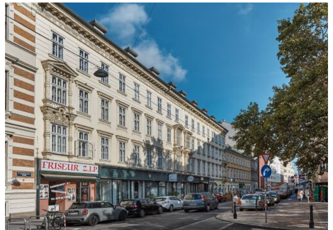
Schönbrunner Straße 20-24 | Fassade
