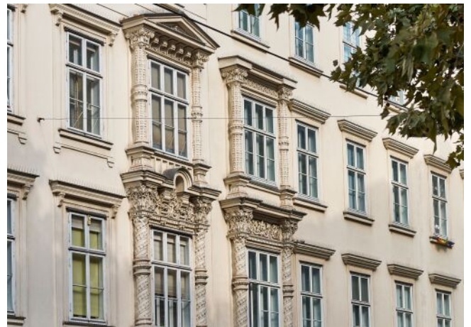
Schönbrunner Straße 20-24 | Fassade
