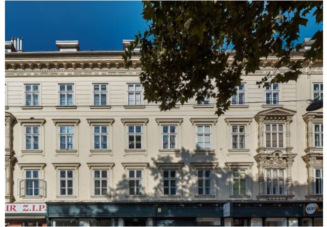
Schönbrunner Straße 20-24 | Fassade
