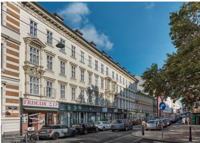
Schönbrunner Straße 20-24 | Fassade
