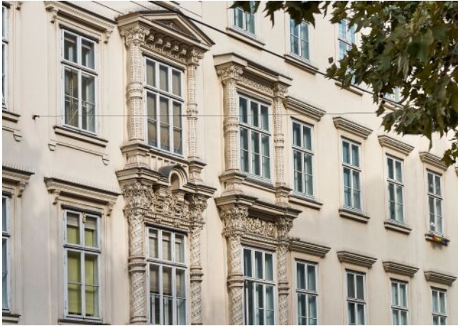
Schönbrunner Straße 20-24 | Fassade
