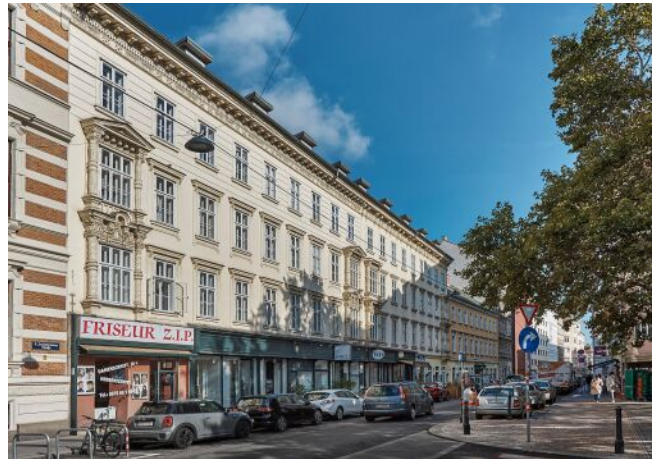
Schönbrunner Straße 20-24 | Fassade
