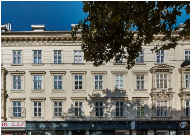
Schönbrunner Straße 20-24 | Fassade
