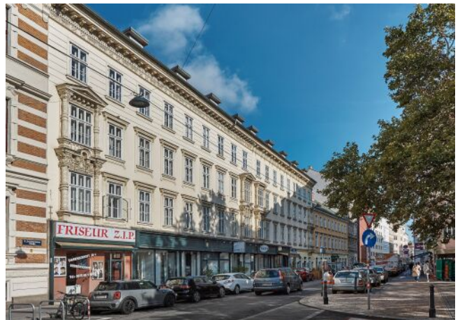
Schönbrunner Straße 20-24 | Fassade
