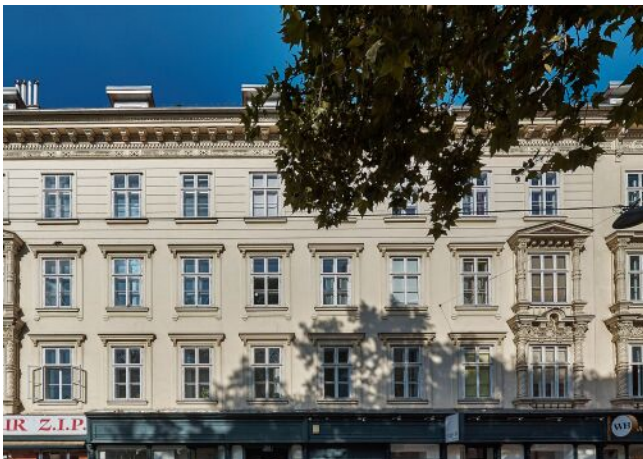
Schönbrunner Straße 20-24 | Fassade
