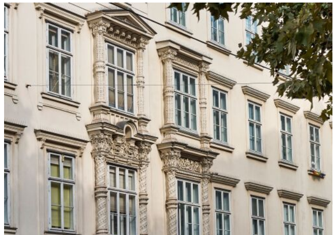
Schönbrunner Straße 20-24 | Fassade
