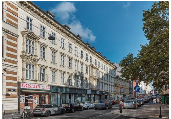
Schönbrunner Straße 20-24 | Fassade
