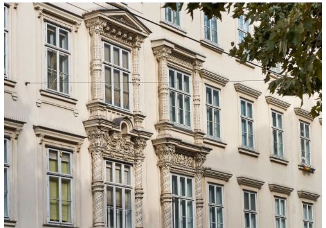
Schönbrunner Straße 20-24 | Fassade
