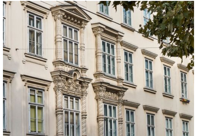
Schönbrunner Straße 20-24 | Fassade
