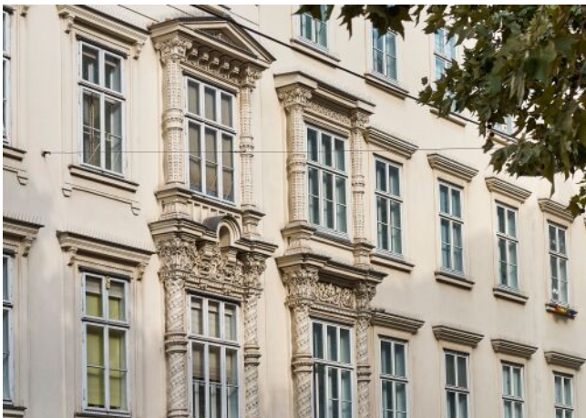
Schönbrunner Straße 20-24 | Fassade
