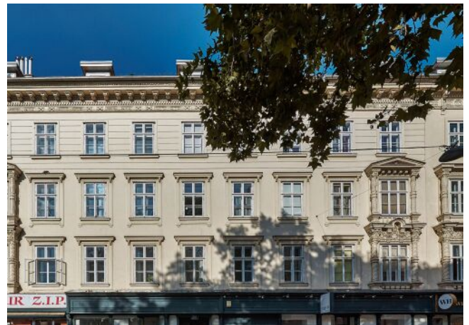
Schönbrunner Straße 20-24 | Fassade
