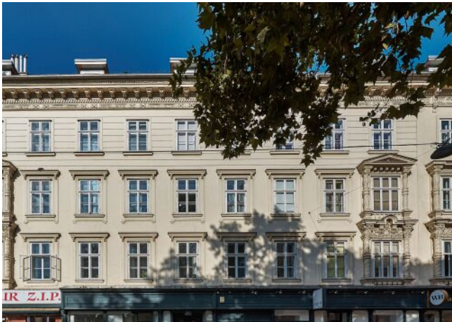
Schönbrunner Straße 20-24 | Fassade
