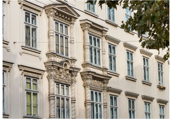
Schönbrunner Straße 20-24 | Fassade
