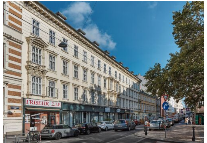
Schönbrunner Straße 20-24 | Fassade
