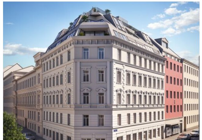
Vivienne | Fassade Tag
