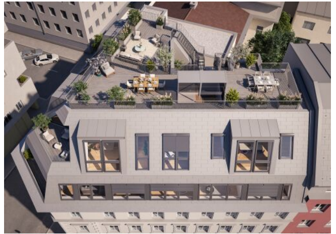
Vivienne | Fassade Tag
