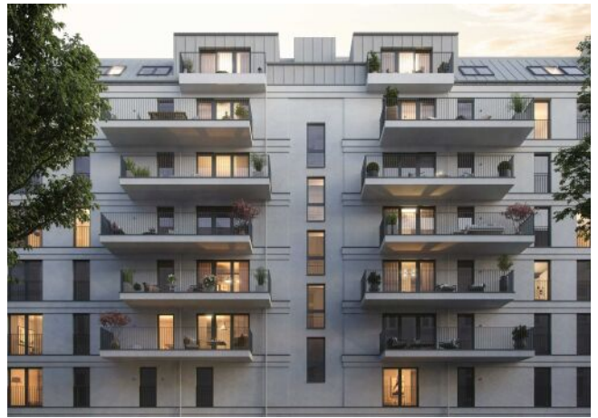
Wiedner Hauptstrasse 140 | Fassade Straße
