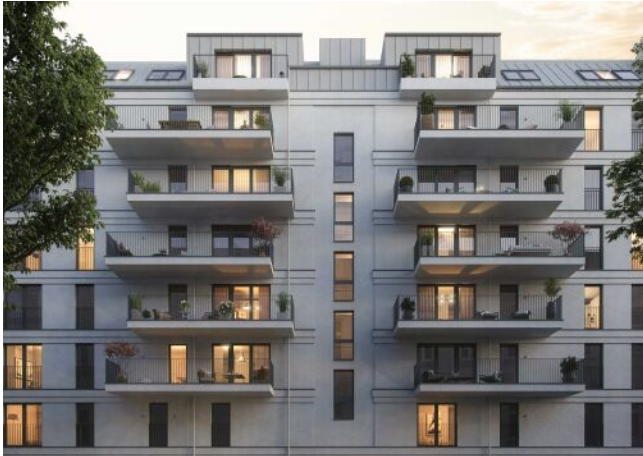
Wiedner Hauptstrasse 140 | Fassade Straße
