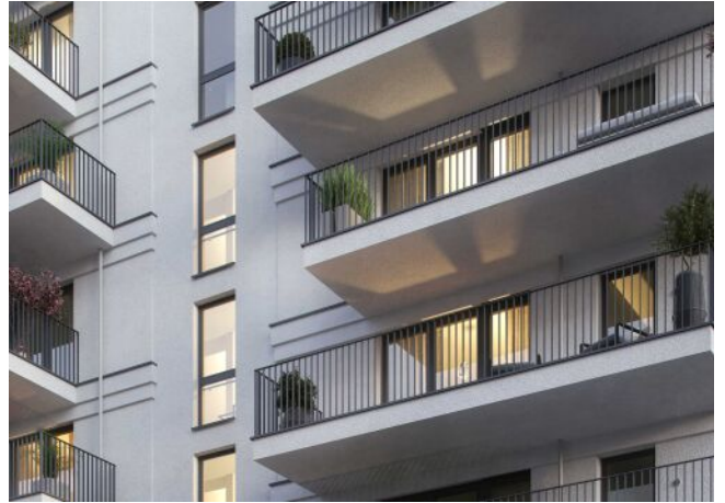
Wiedner Hauptstrasse 140 | Fassade Straße
