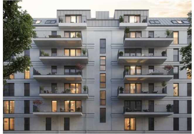
Wiedner Hauptstrasse 140 | Fassade Straße
