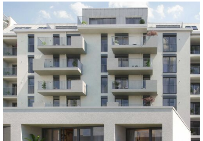
Wiedner Hauptstrasse 140 | Fassade Hof
