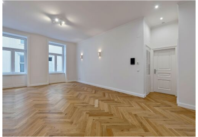
Beispielfoto nach Sanierung
