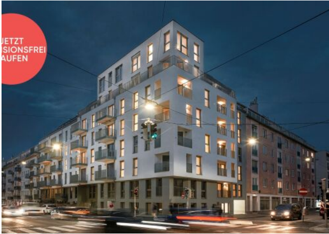
Arndtstraße 50 | Fassade Nacht
