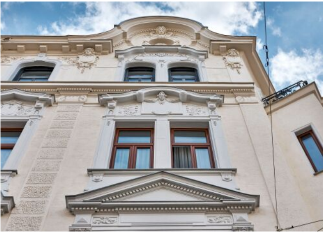
Bergsteiggasse 26A | Fassade
