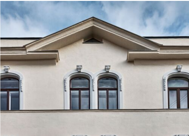
Bergsteiggasse 26A | Fassade
