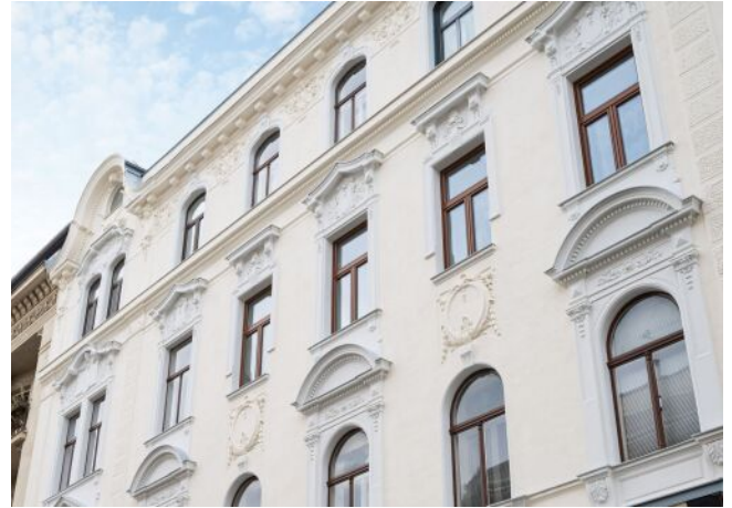
Bergsteiggasse 26A | Fassade
