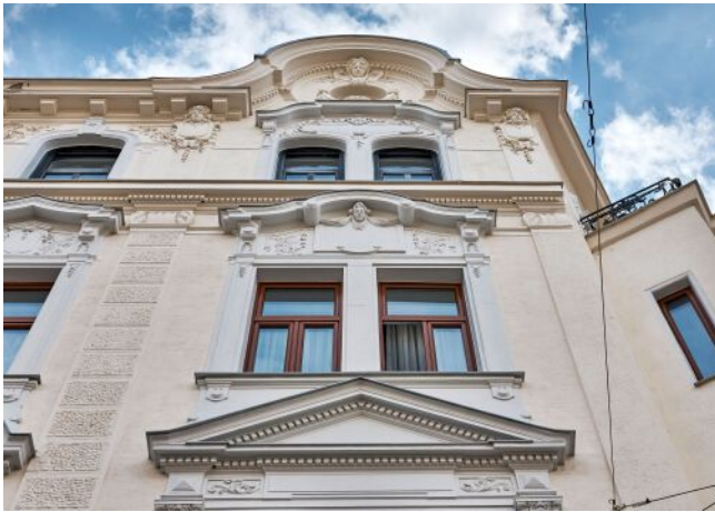
Bergsteiggasse 26A | Fassade
