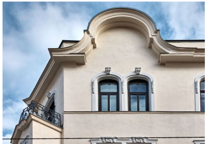
Bergsteiggasse 26A | Fassade
