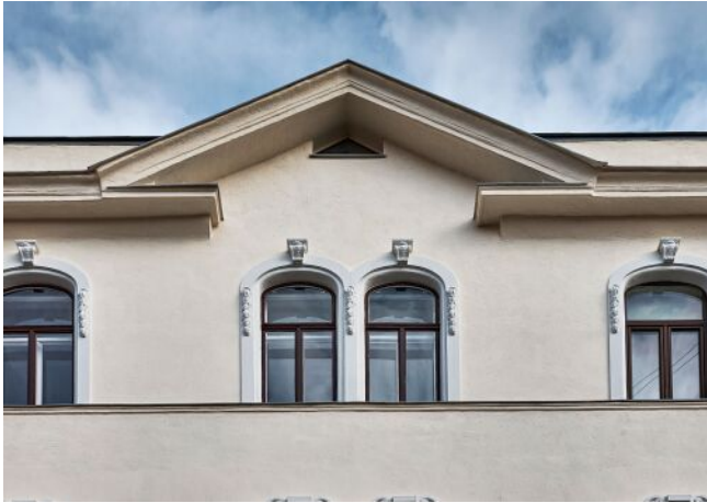
Bergsteiggasse 26A | Fassade
