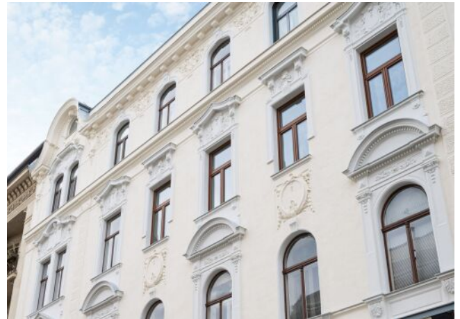
Bergsteiggasse 26A | Fassade
