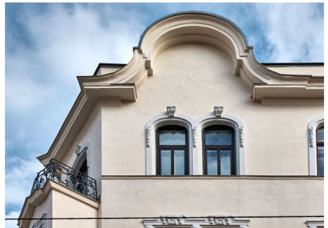
Bergsteiggasse 26A | Fassade
