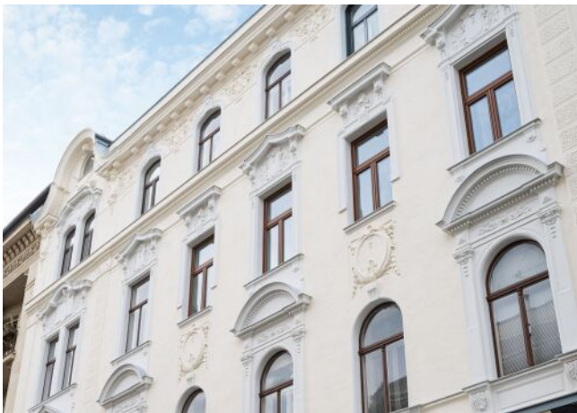
Bergsteiggasse 26A | Fassade
