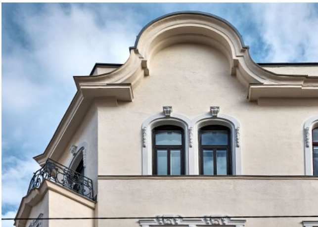
Bergsteiggasse 26A | Fassade
