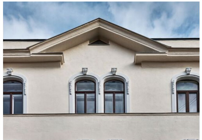
Bergsteiggasse 26A | Fassade
