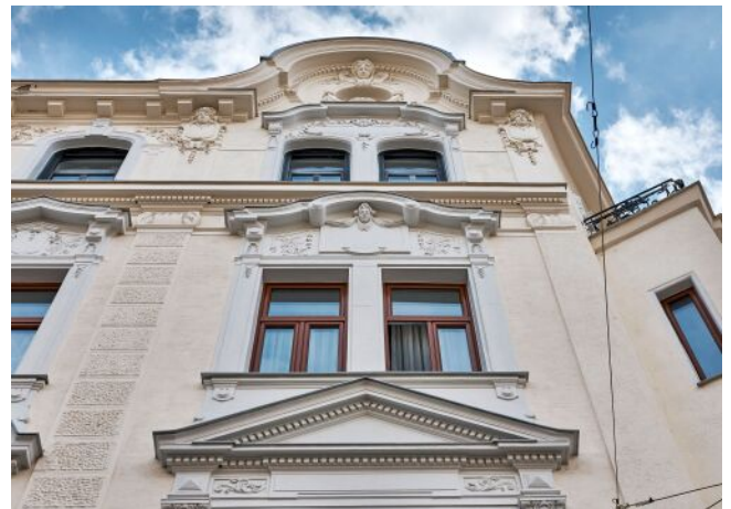
Bergsteiggasse 26A | Fassade
