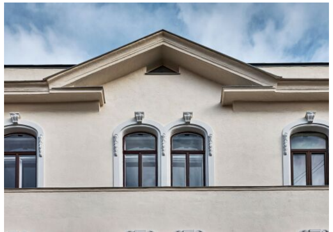
Bergsteiggasse 26A | Fassade
