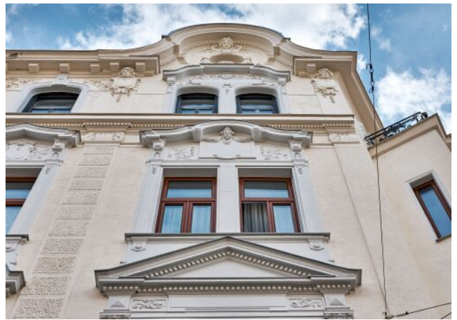
Bergsteiggasse 26A | Fassade
