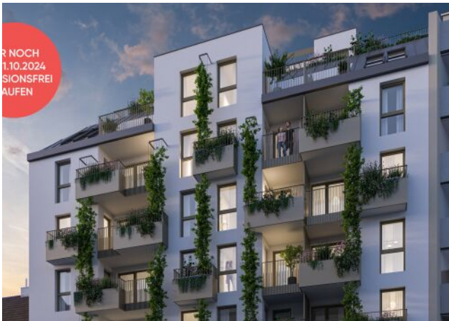
Ottakringer Straße 26 | Straßenansicht
