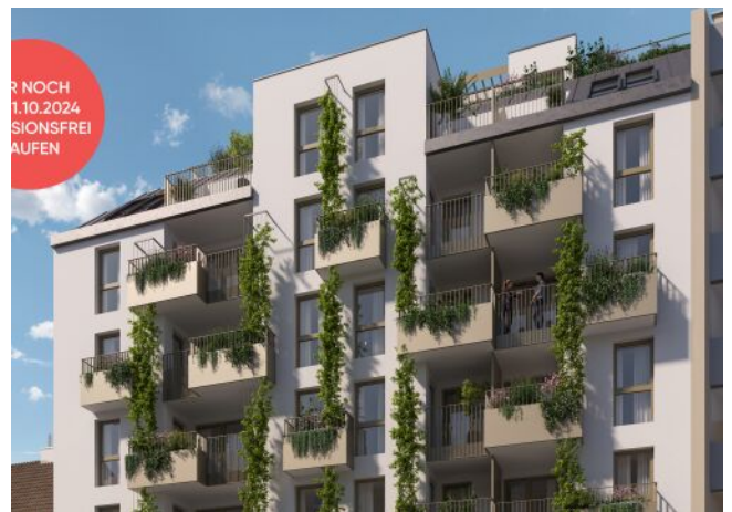
Ottakringer Straße 26 | Fassade
