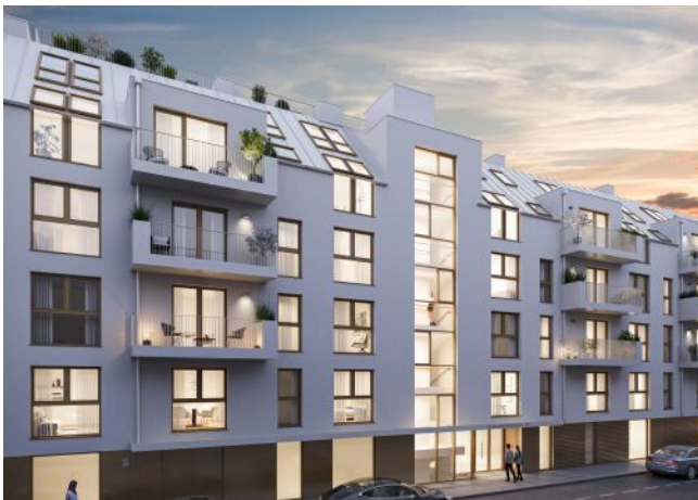
Schumanngasse | Fassade Straße
