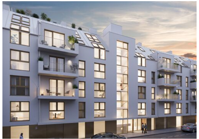
Schumannngasse | Fassade Straße
