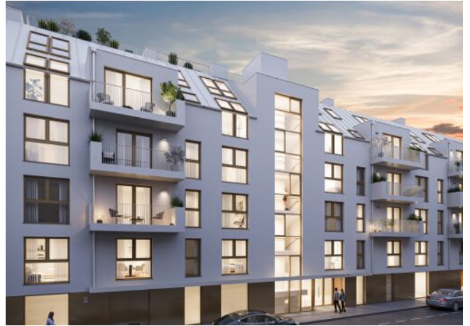
Schumanngasse | Fassade Straße
