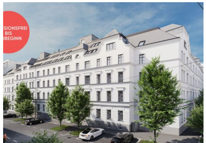
Rosegggasse | Fassade Tag
