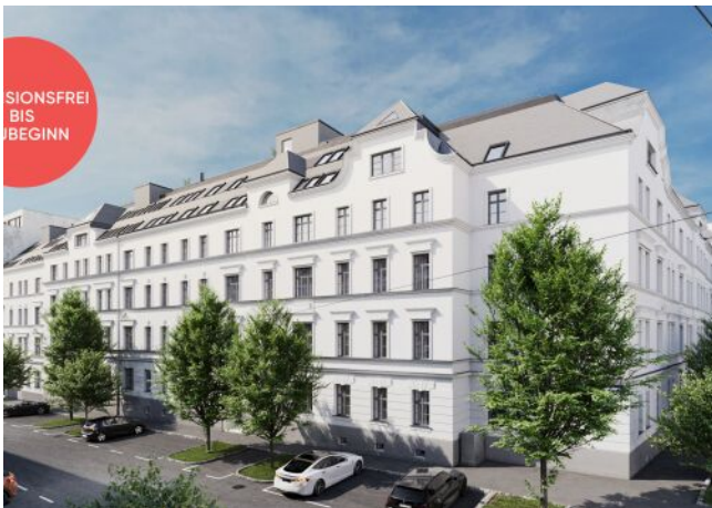
Rosegggasse | Fassade Tag
