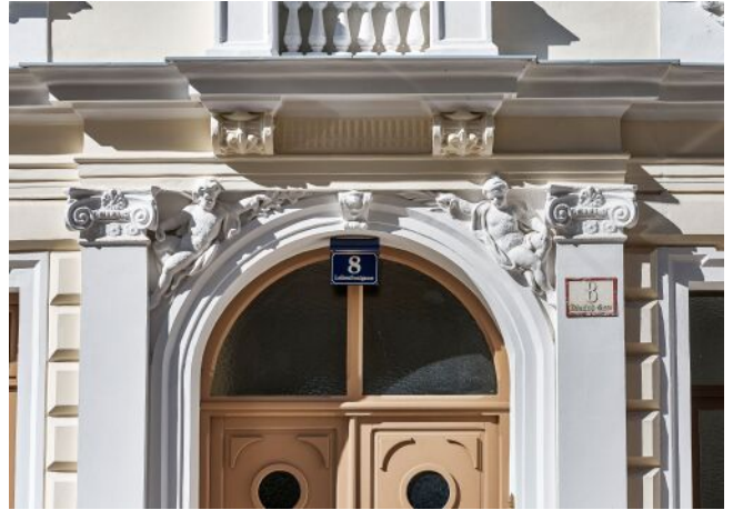
Leibenfrostgasse 8 | Fassade Detail
