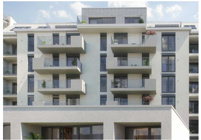
Wiedner Hauptstrasse 140 | Fassade Hof
